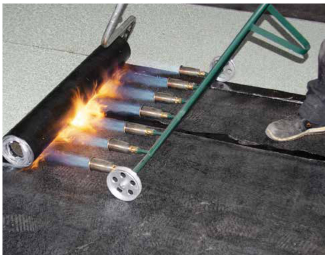
BauderKARAT/BauderSMARAGD pealiskihi keevitamine
