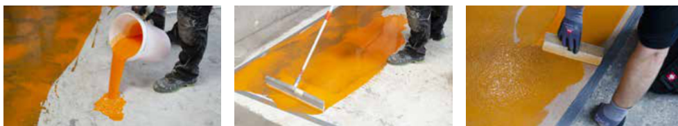
Illustratsioon PMMA vaigu pealekandmise kohta.
