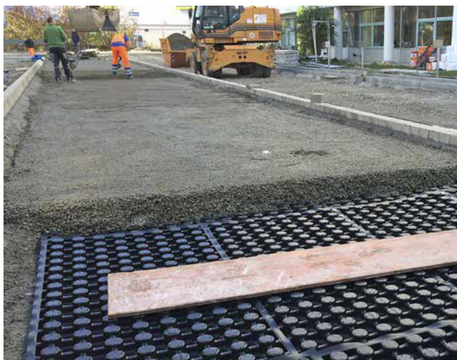
Kandekihi paigaldamine
