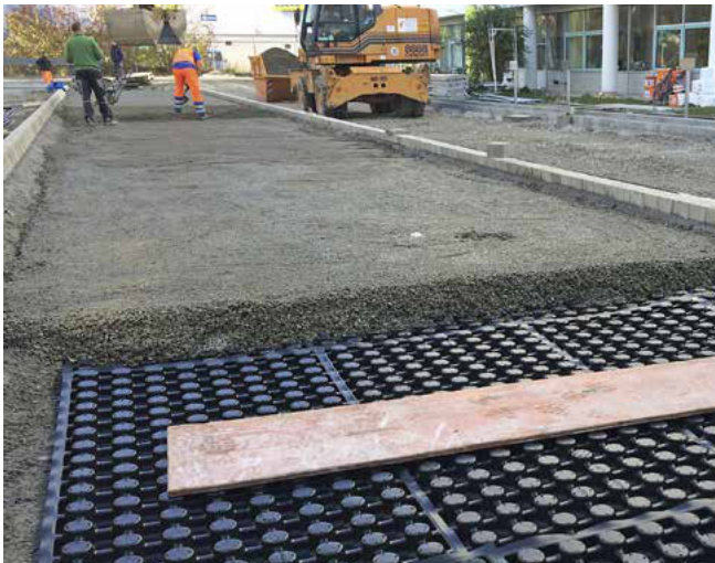
Kandekihi paigaldamine
