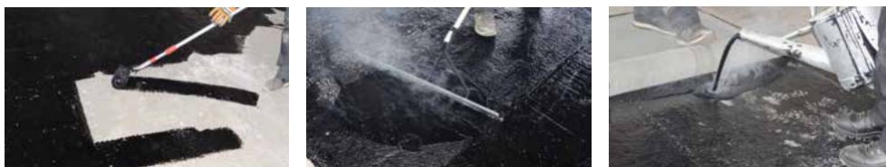
Illustratsioon krundi ja kuumbituumensegu pealekandmise kohta.
