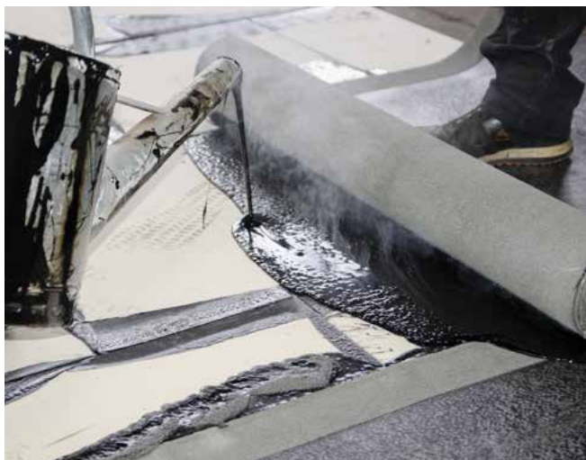
Alumise hüdroisolatsioonikihi BauderKOMPAKT ULK sissevalamine
