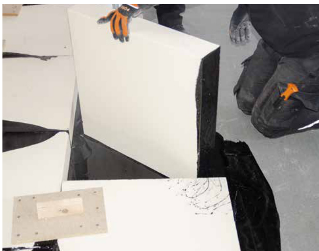
BauderPIR KOMPAKT soojustusplaadi paigaldamine
