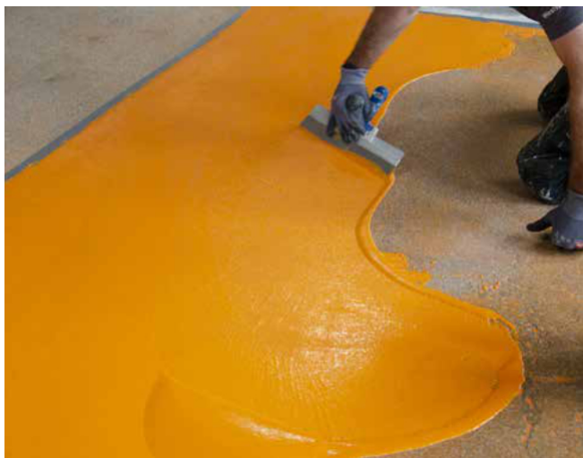
Reaktsioonvaigu (PMMA) pealekandmine
