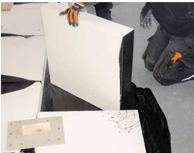
BauderPIR KOMPAKT soojustusplaadi paigaldamine
