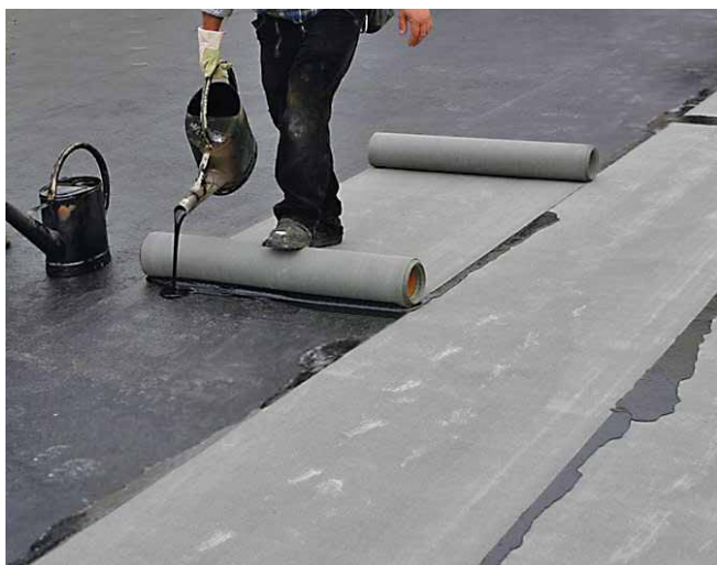
Aurutõkke BauderKOMPACT DSK sissevalamine
